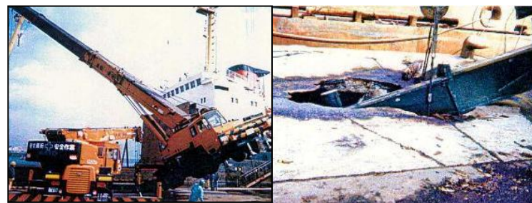
岸壁の陥没によるクレーンの倒壊事故
