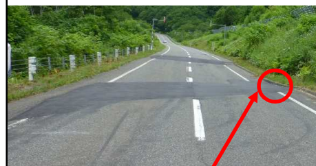
【写真】 (地すべりに伴う舗装変状及び補修状況)
