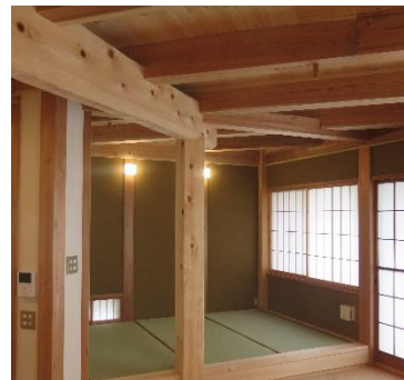
大断面構造体+部材現し
