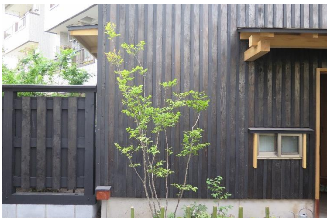
古色塗りの板張り外壁
