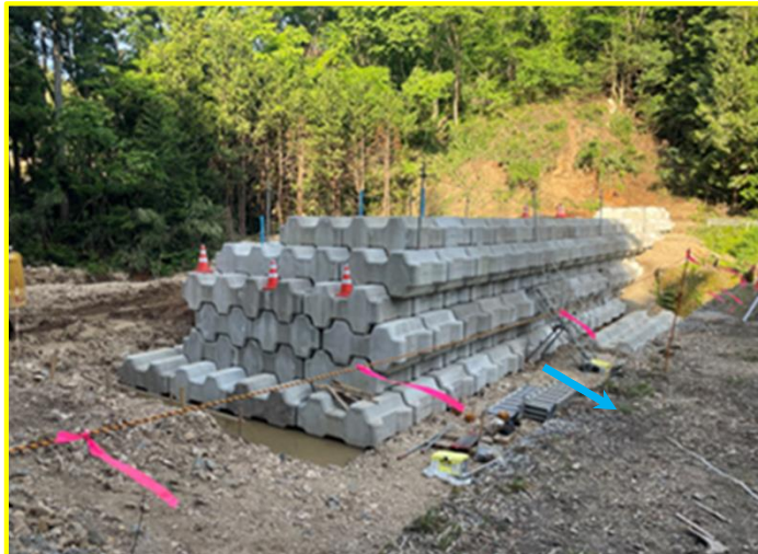
ブロック堰堤設置状況
