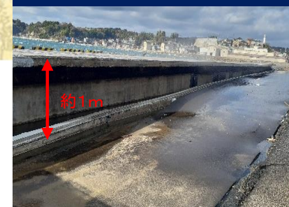
岸壁背後の沈下
