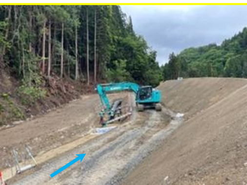
応急対策工事状況（紅葉川） 仮排水路設置
