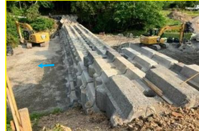
ブロック堰堤設置状況
