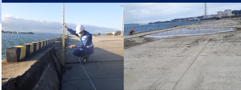
岸壁の沈下
