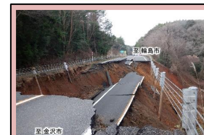
写真⑤ 能越自動車道の道路崩壊
