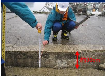
岸壁背後の沈下
