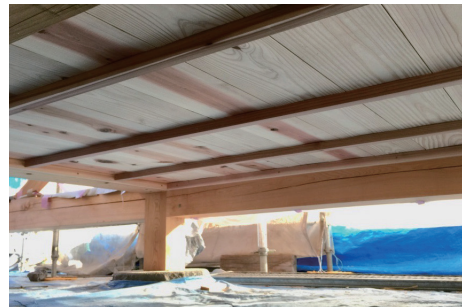
写真 3-8 断熱材が露出しないような対策を講じた開放的な床下
