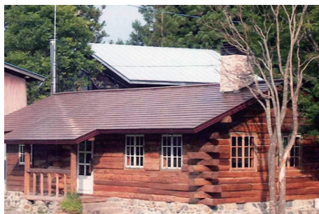
写真 3-5 丸太組構法 外部両面丸太現し（外部）
