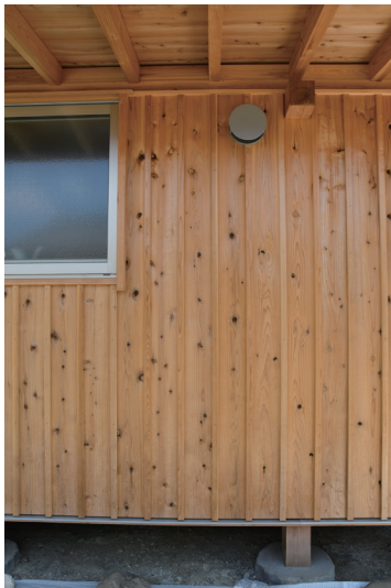
写真 2-13 面戸板現し（外部）
