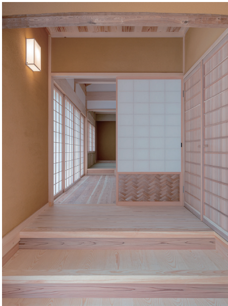
①土塗壁と無垢材により高い調湿性能のある玄関
