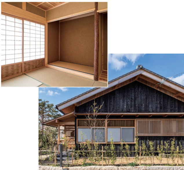
写真2-4 片面真壁造の土塗壁
