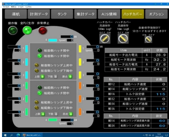
(a) 電動ハッチカバーの監視画面
