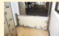
止水板の設置例
