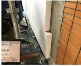
断熱材貼り付け
