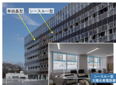
単結晶型パネルとシースルー型パネル
