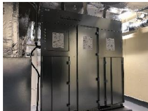
全熱交換器(左: カセット型、右: 床置きダクト型)
