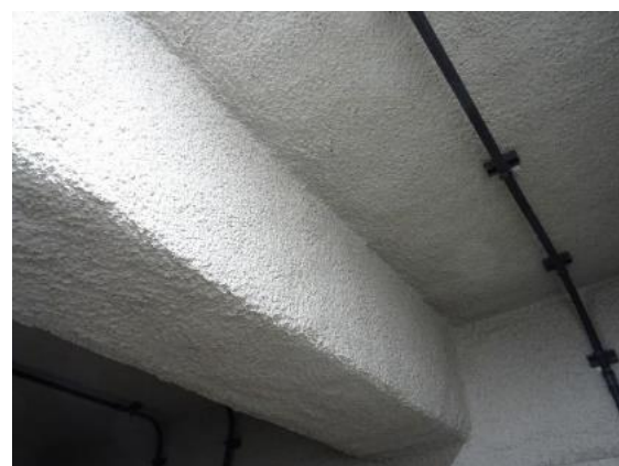
吹き付け式の硬質ウレタンフォーム (千葉市新庁舎)
