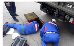
▲漏水箇所の特定
