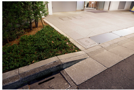
敷地内の通路と道路の境界部分の縁石の切下げ
