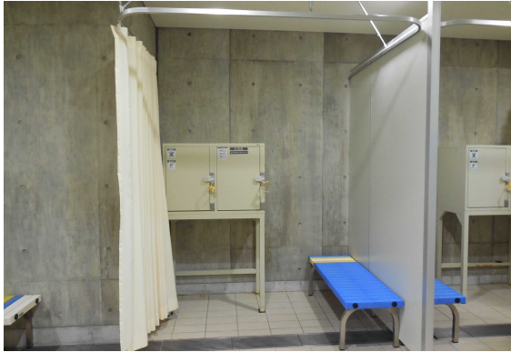
・車椅子使用者の利用に配慮した高さのロッカー、ベンチのある更衣ブース
