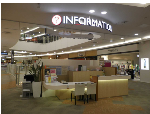
・立位のカウンターの横に設けられた、ローカウンター（商業施設のインフォメーション）
