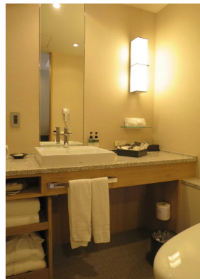
・下部に車椅子使用者の膝が入るスペースを確保した洗面台
