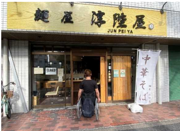
・手動式引き戸（有効幅員110cm）が設けられた出入口
