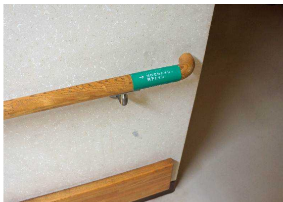
・階段の手すりの点字・墨字（文字）表示
