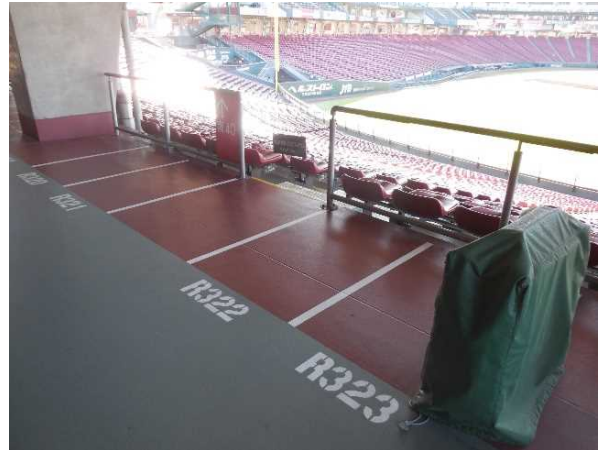
・座席番号がわかりやすく表示され、サイトラインが確保された車椅子使用者用観覧席（カバーがかかっているのは、可動式の同伴者席）
