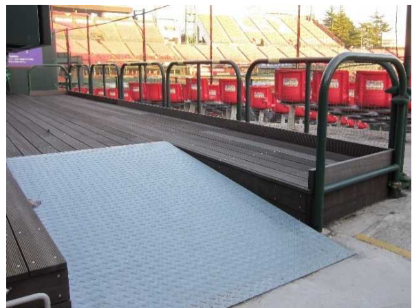
・改修により、内野席に設けられた車椅子使用者用観覧席（サイトライン確保のため床面を高上げしている）
