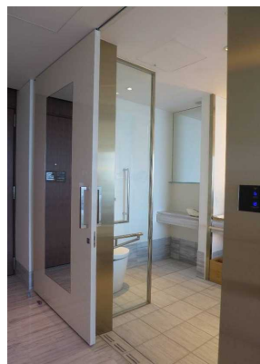
・浴室・洗面所・便房の 出入口の引き戸
