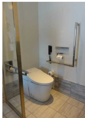
・両側手すり
