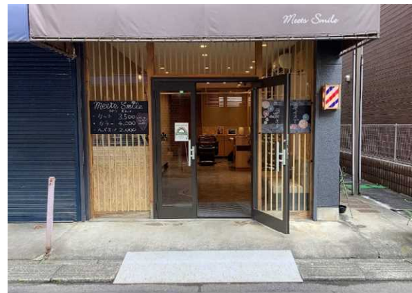
・手動式開き戸（親子扉、合計の有効幅員140cm）が設けられた出入口
