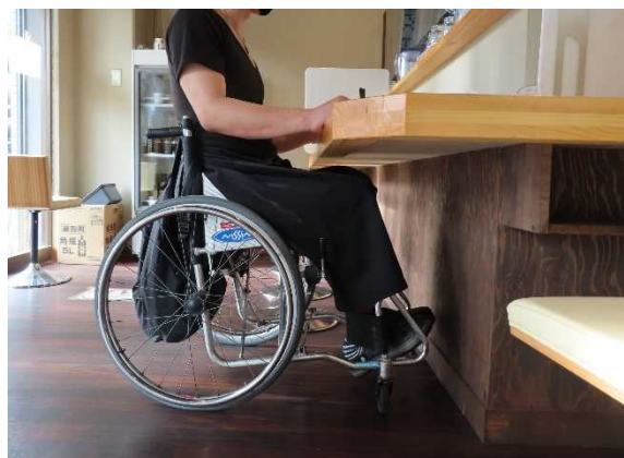
・可動式の椅子席（カウンター席） カウンターの下端高さ：68cm、上端高さ：75cm、奥行き：49cm
