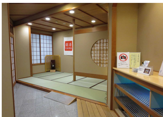
・スロープで上がり框の段を解消した脱衣室
