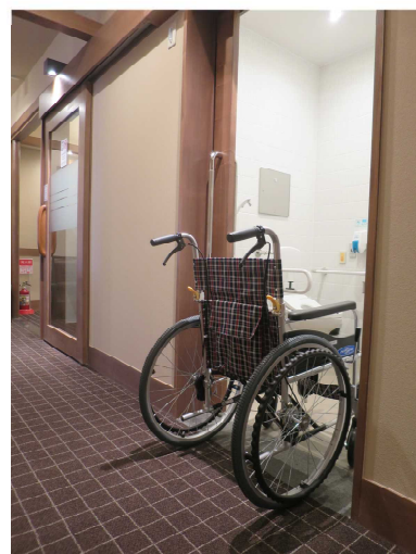
・手動式引き戸が設けられた車椅子使用者用便房の出入口
