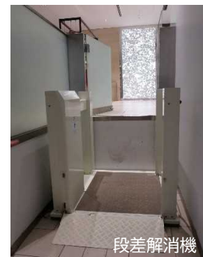
段差解消機スペースのドア
