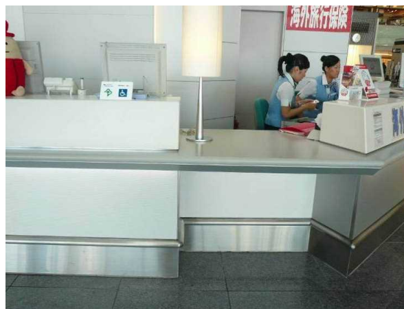
・車椅子使用者の膝が入るように設計されたローカウンター
