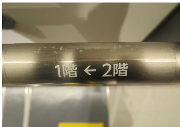
・階段の手すりの点字・墨字（文字）表示
