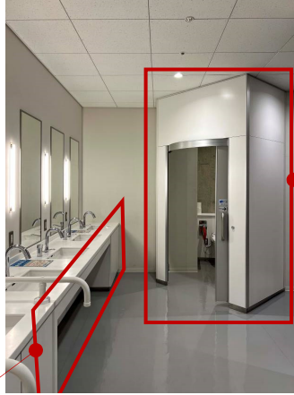
【改修後】更衣室の車椅子使用者用便房、洗面台
