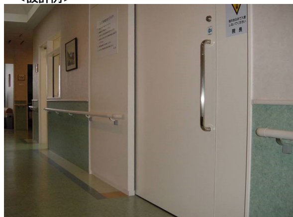
・引き戸の戸袋部分にも連続して設けられた手すり
