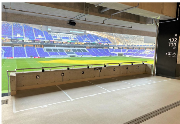
・車椅子使用者と同伴者のスペースがセットになった客席 ・前面の手すりは、床面から75cmとし、サイトラインの確保及び観戦時の安全性の確保のため、形状を工夫している。
