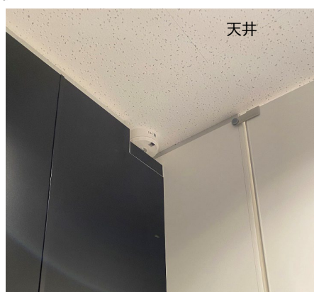
・便所内の上部に設けられた光警報装置
