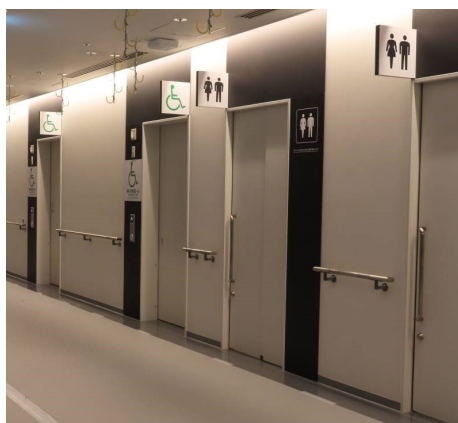
・各種男女共用便房の表示と配置例 1 複数の男女共用車椅子使用者用便房を設置
