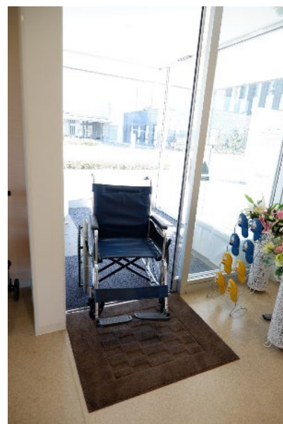
・出入口の前後に高低差のない自動式引き戸（出入口の有効幅員：85cm）
