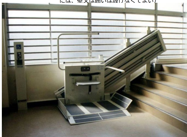
・既存施設の階段に設置した斜行型段差解消機
