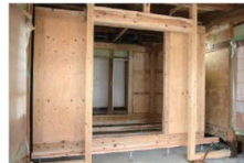
耐震改修工事例
