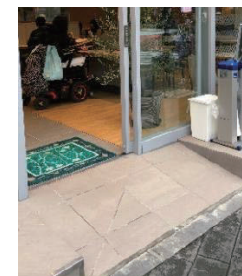
スロープの設置
