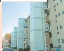
エレベータ設置
