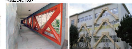
鉄骨ブレースによる壁の補強
