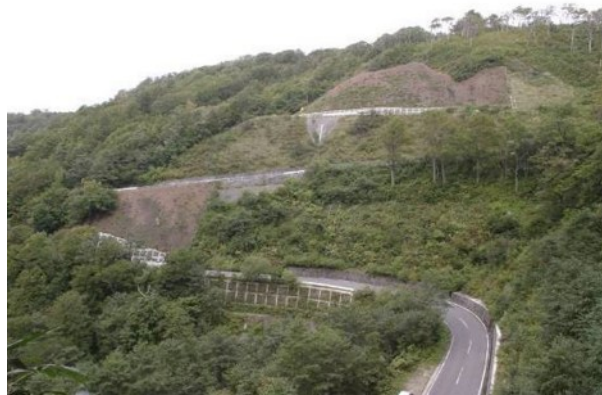
▲国道102号七曲区間のつづら折り区間
