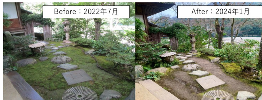
臥龍山荘の名勝指定された庭園の苔が剥がれている様子
