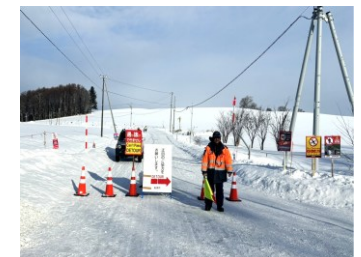
クリスマスツリーの木における 警備員配置状況 (令和8年1月)
