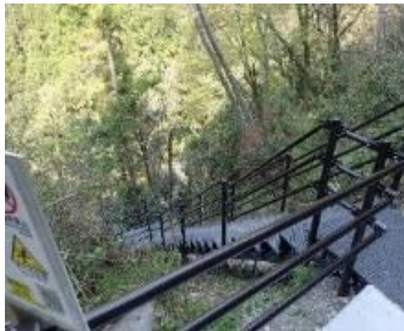
既存の階段（傾斜が急で幅が狭い）
