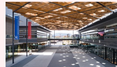
【奈良県コンベンションセンター】
