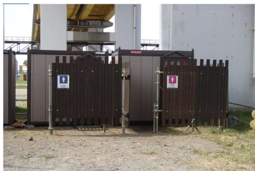
準備工の仮設トイレ設置
