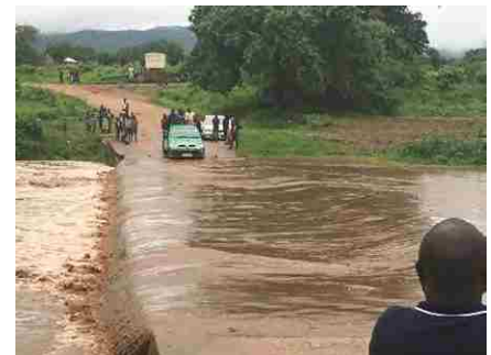
図 2.1-1 雨季の降雨で水没したヘルスセンターへの道路（ザンビア南部州）
