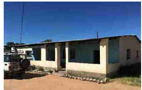
ポポタ RHC・建物の外観
