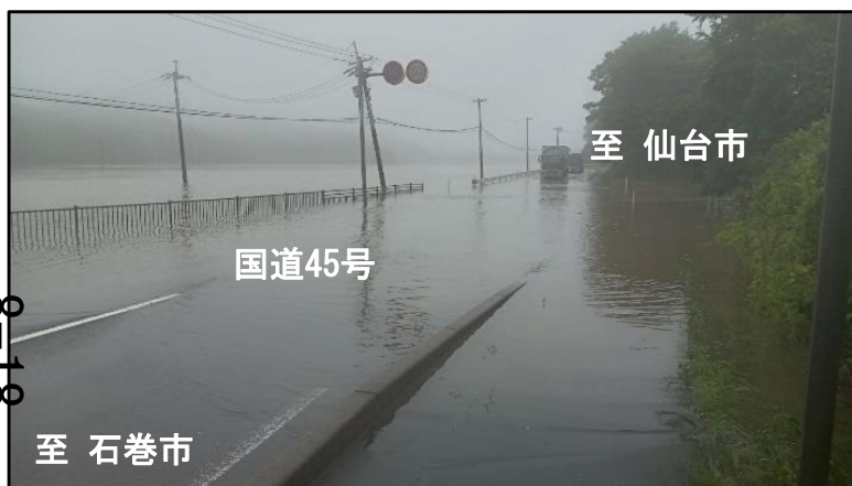
【被害状況写真】
