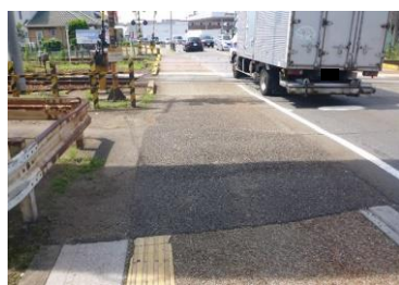
【写真①(踏切付近)】
