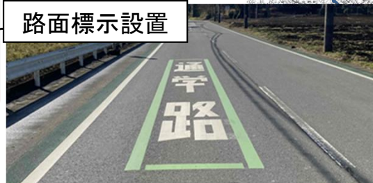
グリーンベルト設置
