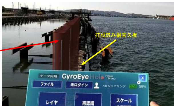
打設済み鋼管矢板への3次元モデル投影(MR)
