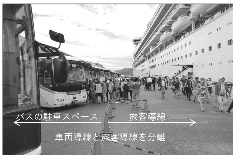
先導的事業実施状況：清水港
