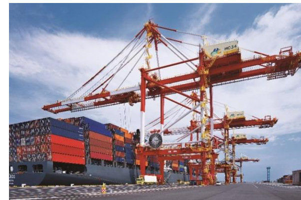
ガントリークレーン
