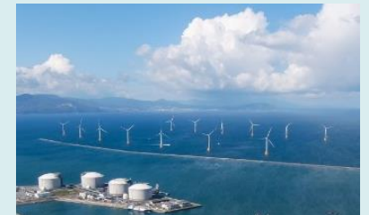
写真提供: 石狩湾新港管理組合
