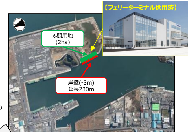
【北九州港におけるフェリー岸壁等の整備(R3dに供用開始)】
