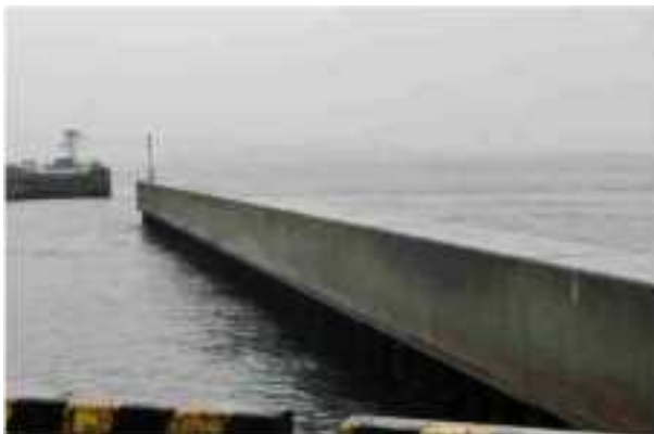
（陸上目視の点検状況）
