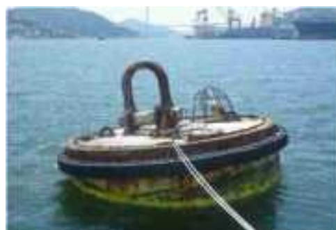
写真 3-6.3 係船浮標の外観
