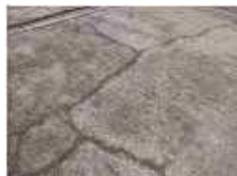
写真 3-6.5 斜路部の変状事例
