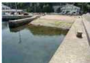
写真 3-6.4 船揚場の全景
