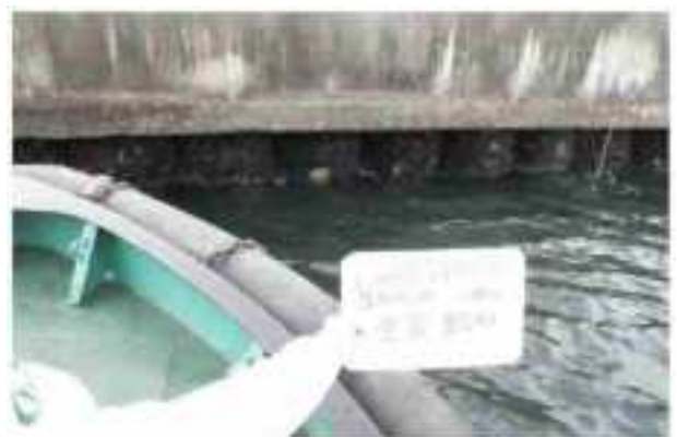
（海上目視調査の点検状況）
