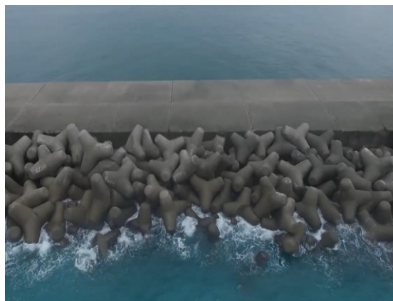
①消波工沈下（変状なし）動画ファイル1：5分10秒頃
