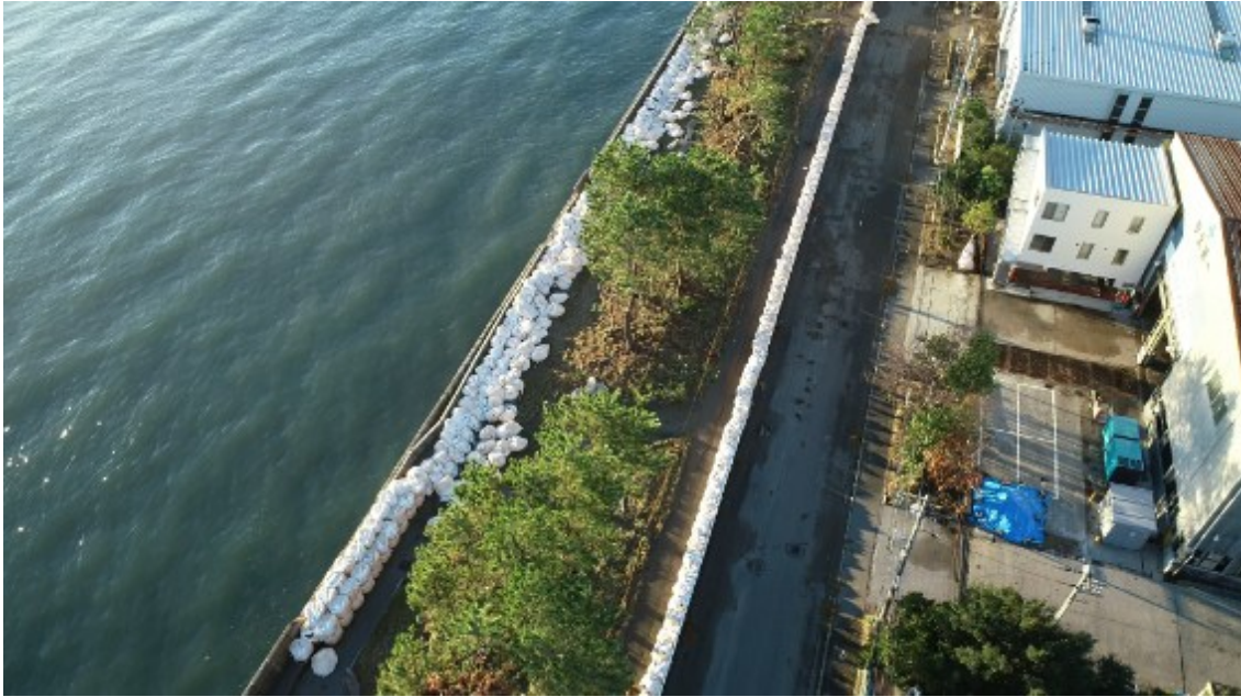
図－6 金沢区福浦地区 パラペットの土嚢は飛散したもの、背後の土嚢は飛散していない
