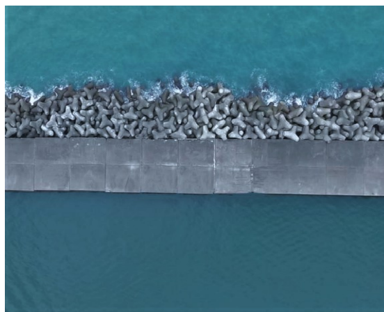
③本体工のずれ（変状なし）動画ファイル2：5分03秒頃
