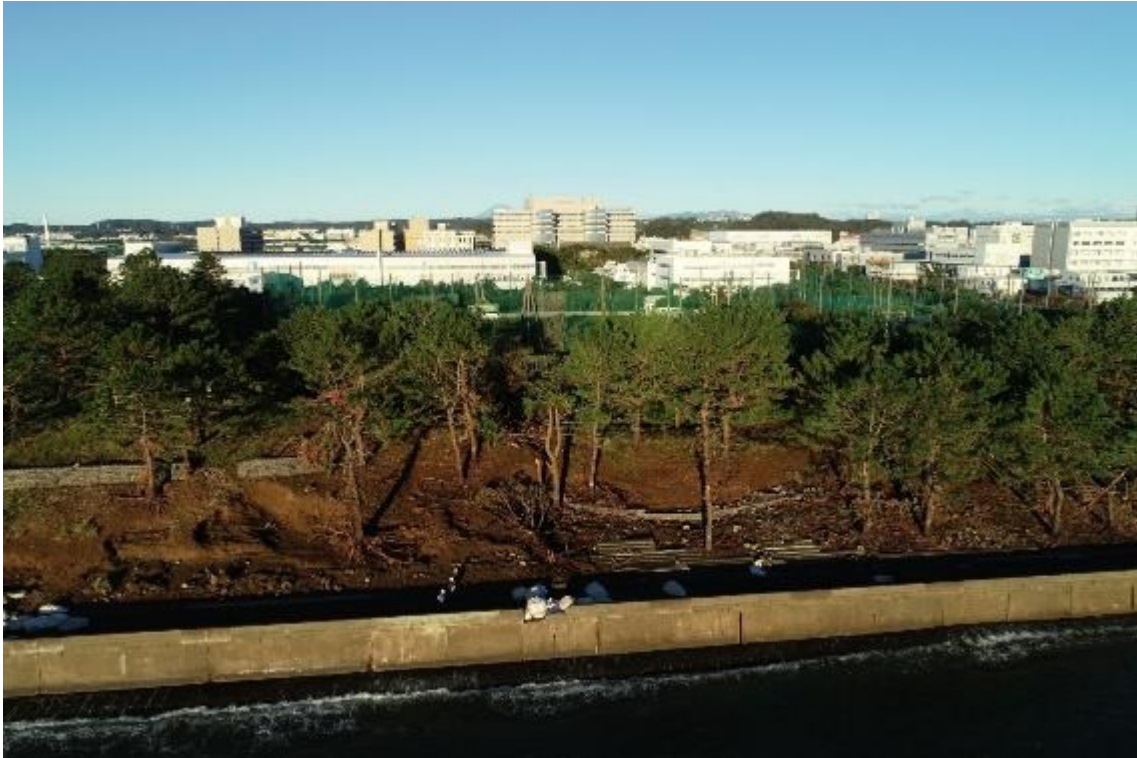
図－4 金沢区福浦地区 築山付近
