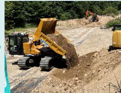
遠隔施工（バックホウ）と自動化施工（キャリアダンプ）を合わせた掘削運搬作業
