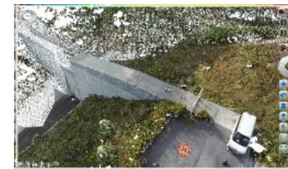
UAVによる目視外自律飛行点検
