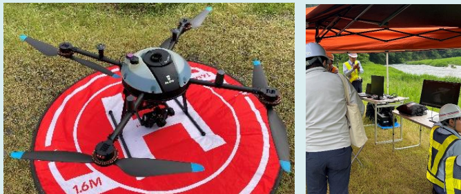
UAVの自律飛行（レベル3.5飛行）を活用した砂防施設点検状況
