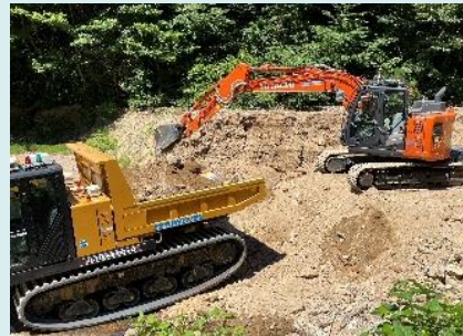
遠隔施工（バックホウ）と自動化施工（キャリアダンプ）を合わせた掘削運搬作業
