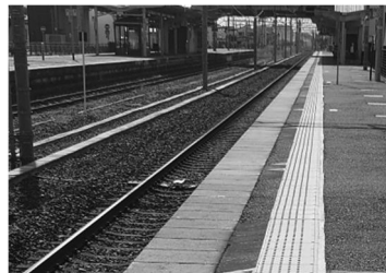
内方線付き点状ブロック
