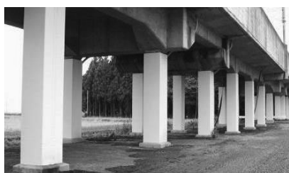
鋼板巻きによる高架橋の耐震対策
