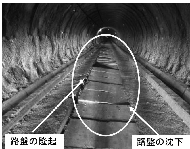
トンネル（先進導坑）の変状
