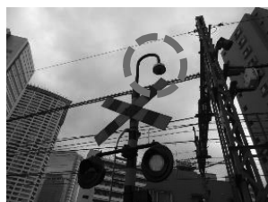
踏切監視用カメラ
