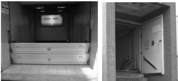
止水板・防水扉の整備
