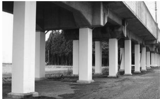
鋼板巻きによる高架橋の耐震対策
