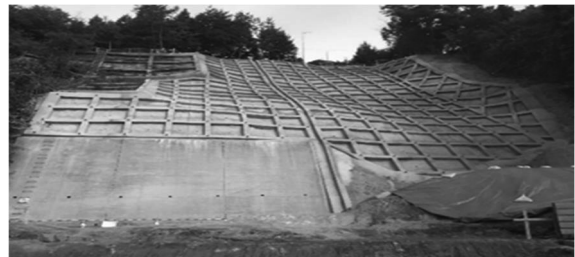
コンクリート枠による斜面の補強
