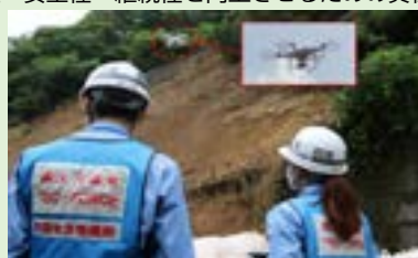
ドローンを用いた被災状況調査
