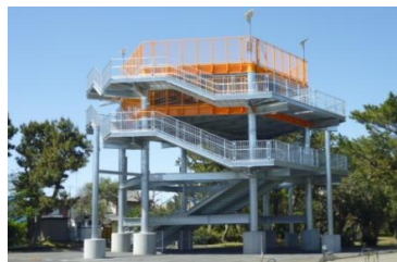
津波避難タワー
