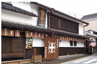
歴史的建造物の修景 (京都府宇治市)
