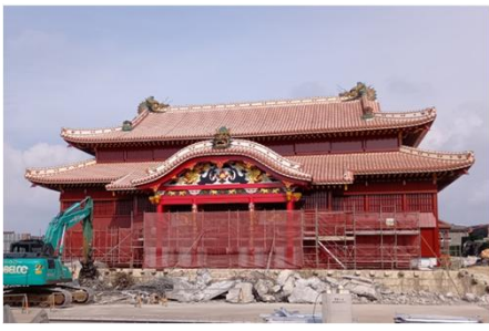
正殿の本体工事（令和7年10月撮影）
