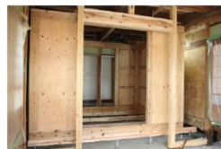
耐震改修工事例
