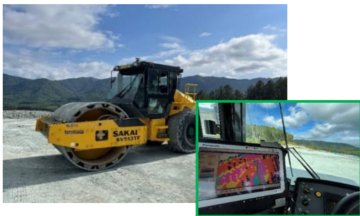
工法規定方式による ICT 土工の様子
