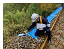
路盤の流出状況の 測定
