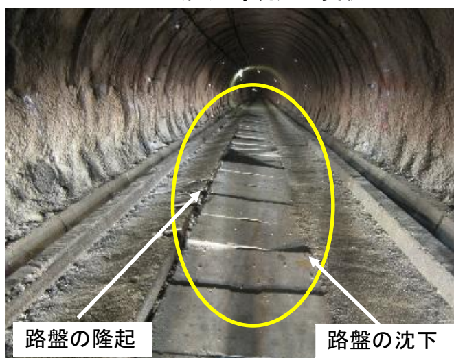
トンネル（先進導坑）の変状
