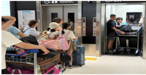
大型エレベーター整備
