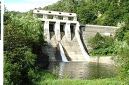
雨竜川ダム再生事業（雨竜第2ダム(幌加内町)）
