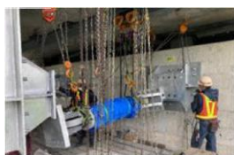
落橋防止装置の設置
