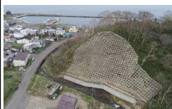
斜面の安定を図る山腹工
