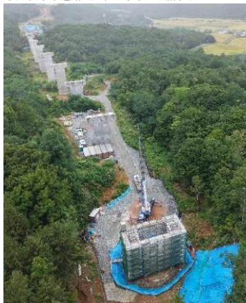
【写真③】 倶知安市道路（共和～余市）整備状況
