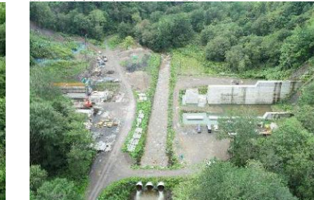
石狩川上流直轄火山砂防事業 (白川第1号砂防堰堤(上川町))
