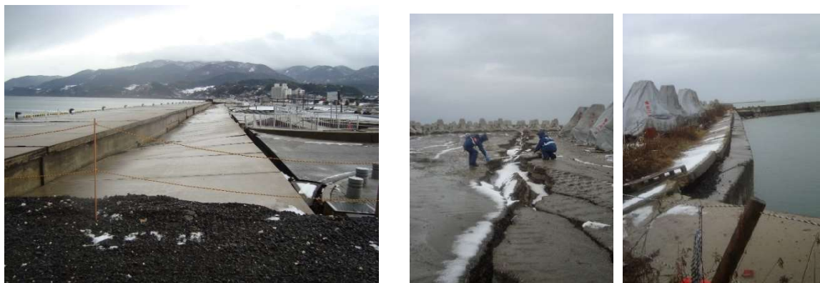
図 1.3.1a-2 令和 6 年能登半島地震による重力式岸壁(左)と矢板式護岸(右)の被害
