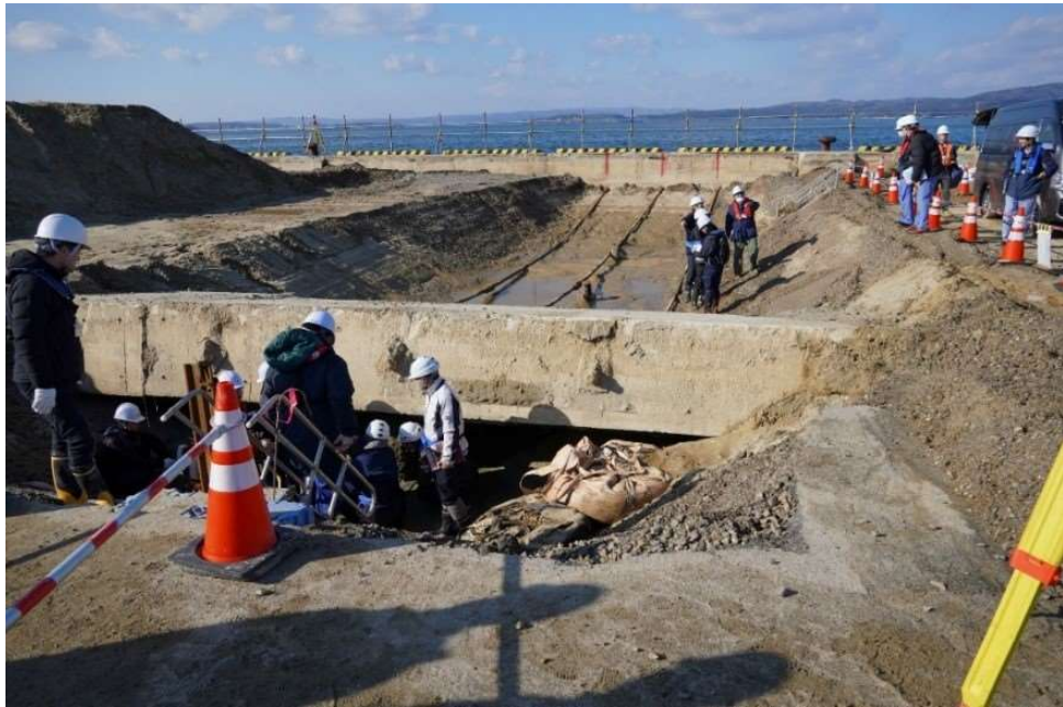
図 I.5.(2).②.1 矢板式岸壁の被災状況調査 (矢板壁頭部とともに控え杭頭部も海側に移動していた) ※図 I.3.(1).①.2 a)矢板式護岸被害の調査の再掲
