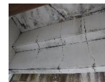
校舎等の天井・壁面 ひび割れや剥離
