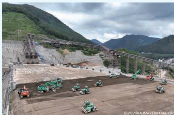
<自動施工の状況>
