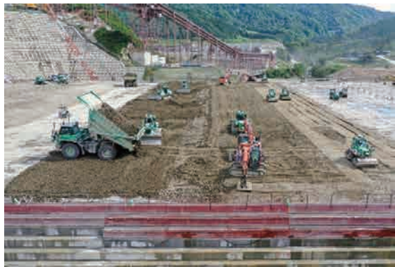
図表 I-2-1-16 重機による自動施工
