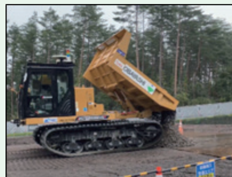
関東地方整備局 地蔵川第一砂防堰堤工事（長野県）
