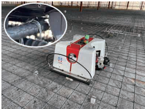
図表 I-2-1-15 鉄筋結束ロボット
