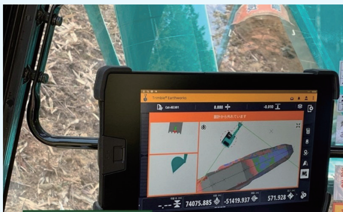
&lt;ICT重機による掘削工&gt;
