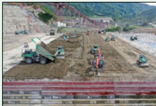
東北地方整備局 成瀬ダム堤体工事（秋田県）
