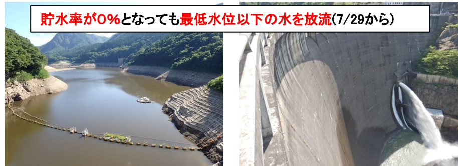
鳴子ダム貯水池(EL.230.84m) 鳴子ダム底水放流状況(7/29撮影)
