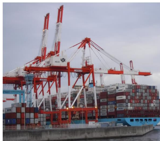
ガントリークレーン (関東地方整備局提供)
