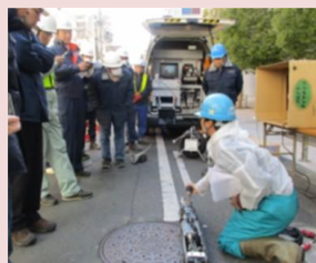
新技術の導入検討のための現場試行の調整
