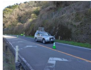
MMS※1を活用した 斜面・のり面点検
