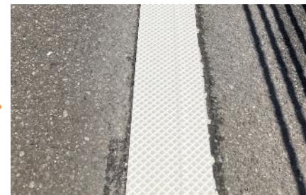
施工完了後 光ケーブルの敷設
