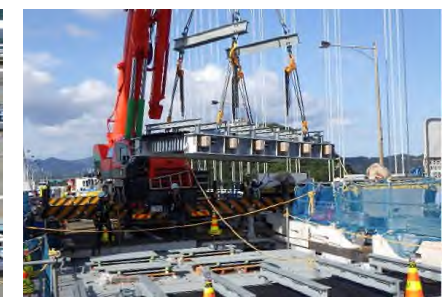
新規伸縮装置の設置状況
