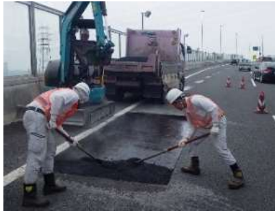
舗装の応急復旧状況
