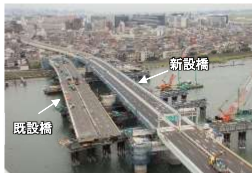
老朽化したコンクリート床板の取替(東名多摩川橋) 新設橋のスライド架設状況(高速大師橋)
