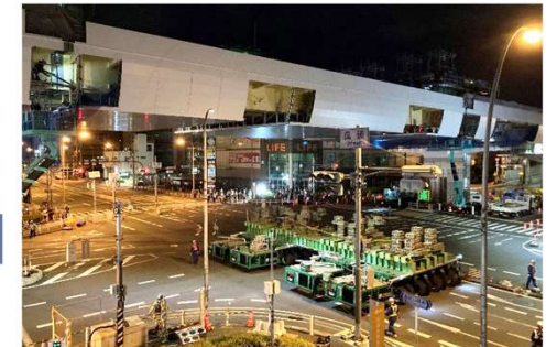
桁の架設状況
