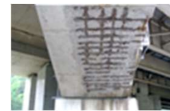
下部工鉄筋腐食・ コンクリート剥離
