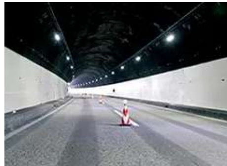
トンネル照明のLED化
