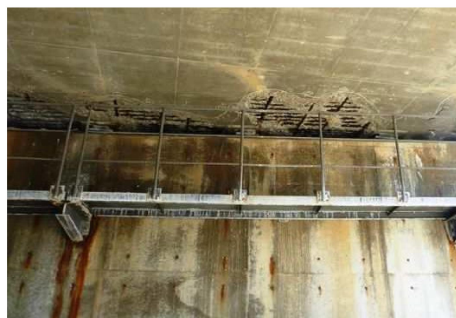
橋台部 塩害損傷
