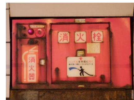
トンネル消火設備 老朽化
