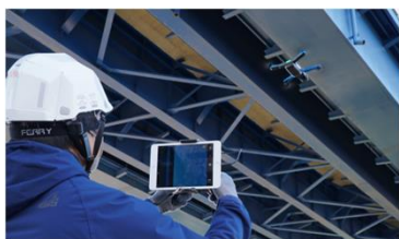
UAV使用による点検状況
