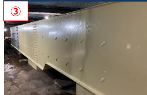
高性能防水の施工状況
