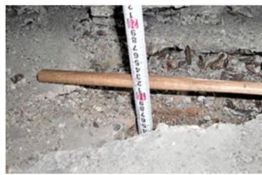
中床版上面のコンクリート剥離
