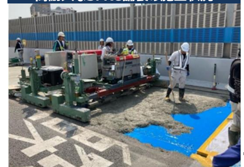
高耐久なSFRC舗装の施工状況
