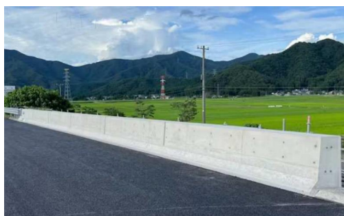
環境配慮型コンクリートによる 橋梁防護柵の施工(北陸道)
