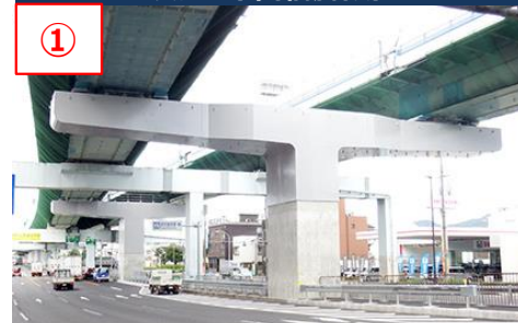
堺線 鋼製フーチング基礎の防食工
