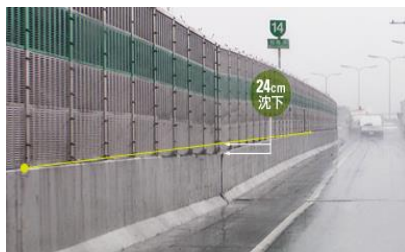
ヒンジ部沈下の状況
