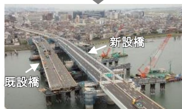
新設橋のスライド架設状況
