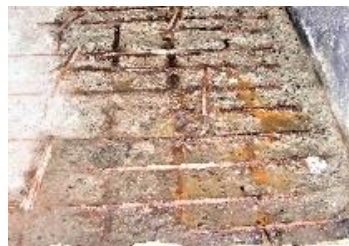
腐食、消失した鉄筋
