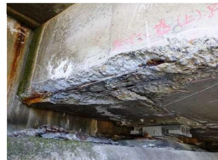
コンクリート桁端部 塩害損傷
