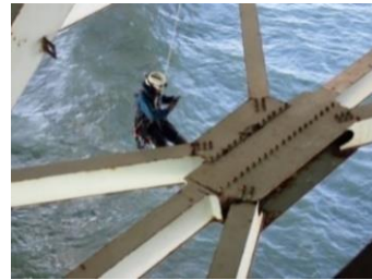
近接点検 (ロープによるアクセス)
