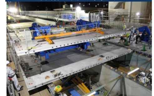
高耐久なSFRC舗装の施工状況
