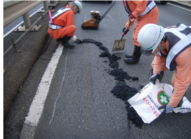
緊急応急状況(舗装の応急復旧)
