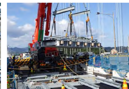
新規伸縮装置の設置状況
