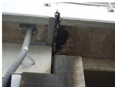
伸縮装置の止水機能不全による 水掛かり
