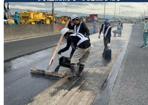
高性能防水の施工状況
