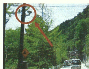
道路監視施設の設置 (ITVカメラ)
