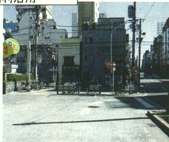
歩道上に自転車駐車場を整備した例
