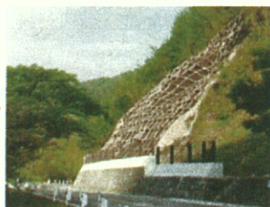
補強・安全対策の実施
