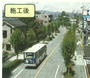
施工後 幅の広い歩道の整備状況。 自転車もスムーズに通ることができる。
