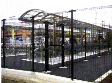
自転車駐車場の整備（上大岡駅）
