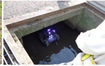
水路進入状況
