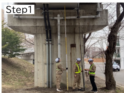
Step1 ロッドカメラを点検対象構造物の下に据置
