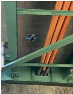
Skydio2+狭隘部侵入不可飛行状況
