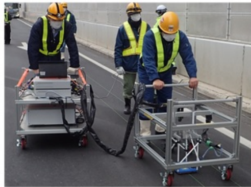
実橋梁での点検作業例
