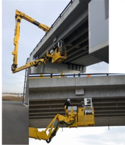
バケット式橋梁点検車を用いた測定例 ※福島ロボットテストフィールドの試験橋梁にて
