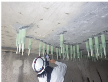
打音検査状況 (床版補修時)
