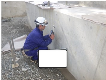
打音検査状況 (橋台打設後)
