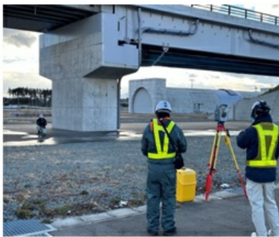
装置設置の位置決め(測量)
