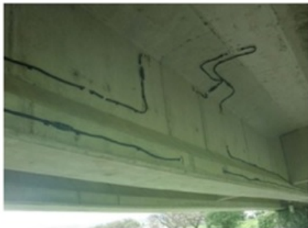
図5 PC単純桁にFBG光ファイバひずみセンサを設置した事例
