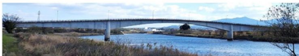
a) PC3径間連続有ヒンジラーメン箱桁橋（支間長266.2m）
